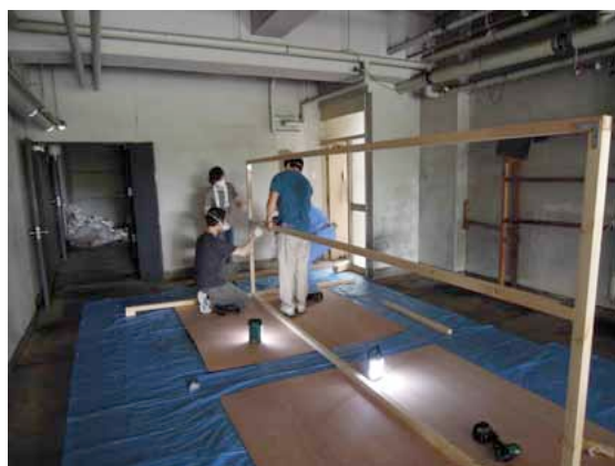
旧衛生研究所でのラック制作作業 2011年7月9日撮影：筆者
