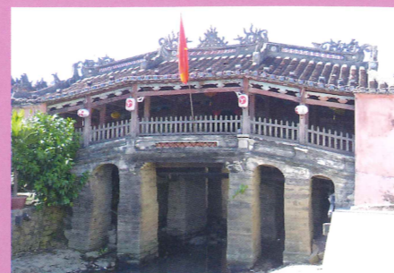
ホイアンの日本橋 Japanese Covered Bridge (Hoi An, Viet Nam)
