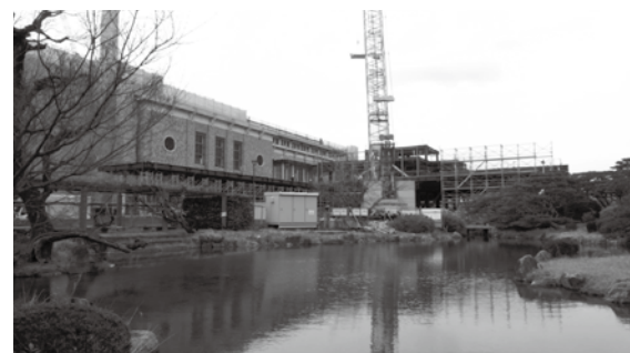
再整備中の京都市美術館（京都市京セラ美術館） 改築中の本館
