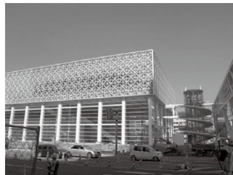
建設途中の大分県立美術館 10月24日撮影
